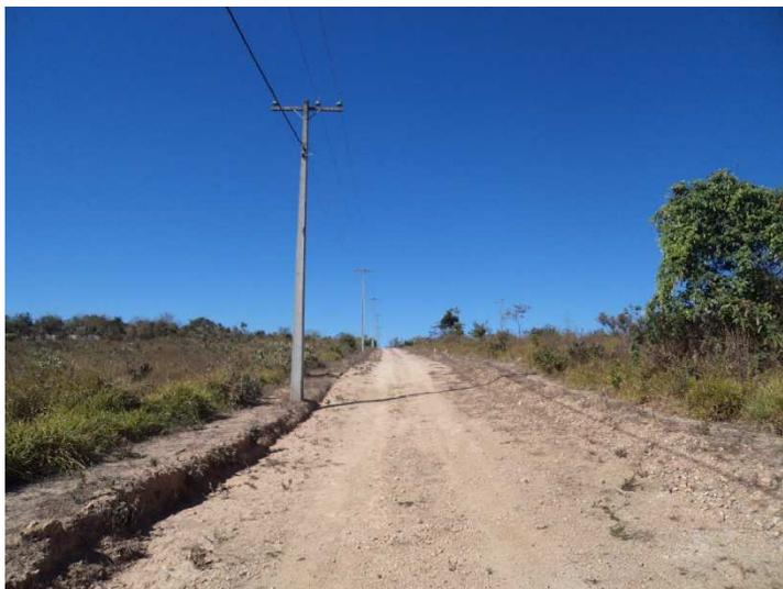
*Figura 113: Aspecto da via interna em solo exposto e com pouco cascalho. Trecho em declive*
