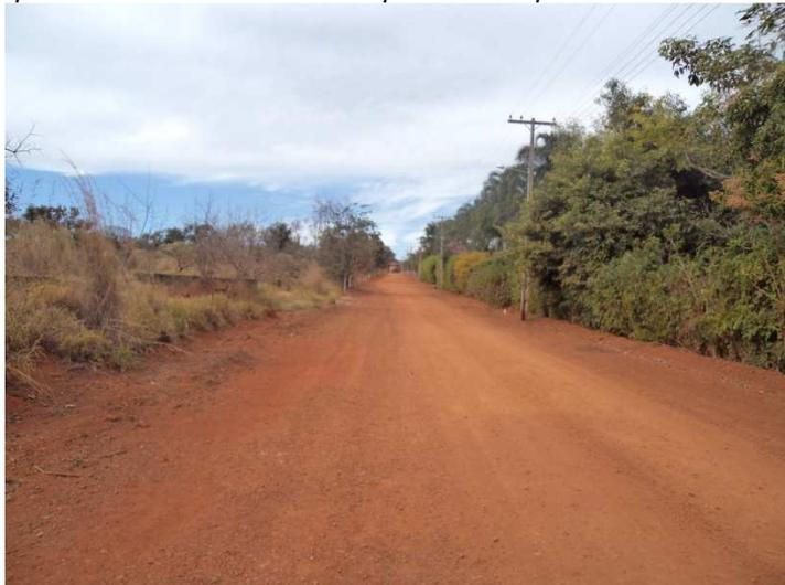
*Figura 114: Aspecto da via interna em solo exposto e com pouco cascalho. Trecho plano*
